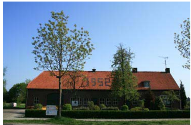
Foto: een van de boerderijen uit de periode van de wederopbouw. Deze staat aan de Buxtelseweg en is opgeleverd in 1952
