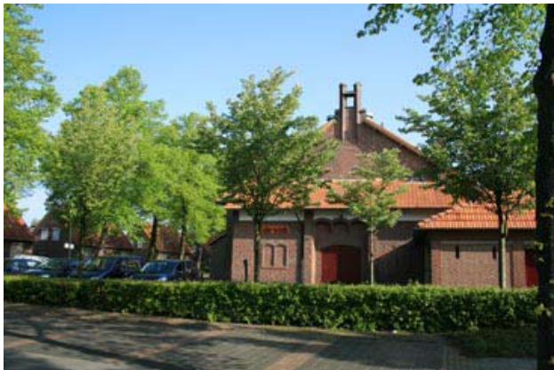
Foto: de voormalige noodkerk past ondanks diverse verbouwingen nog steeds goed in het beeld van de wijk
